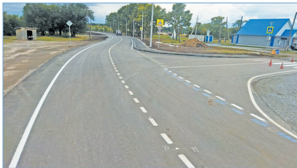
Автодорога к КХ «Енисей» после ремонта
