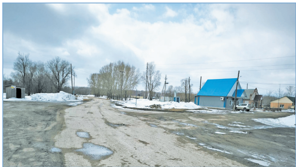
Автодорога к КХ «Енисей» до ремонта
